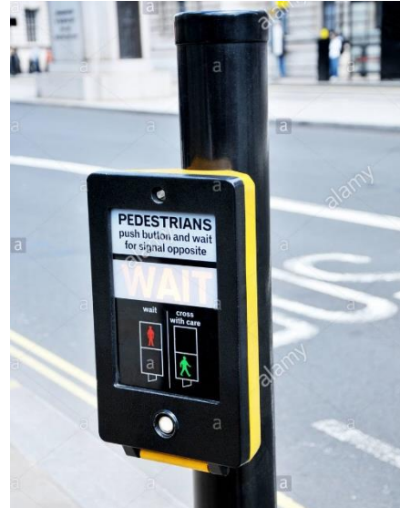
Figură 9-7 Exemplu de instalatie dedicată semnafoarelor pentru pietoni
