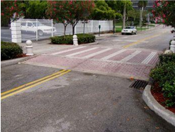
Figură 9-9 Exemplu de trecere pietonală înălțată
